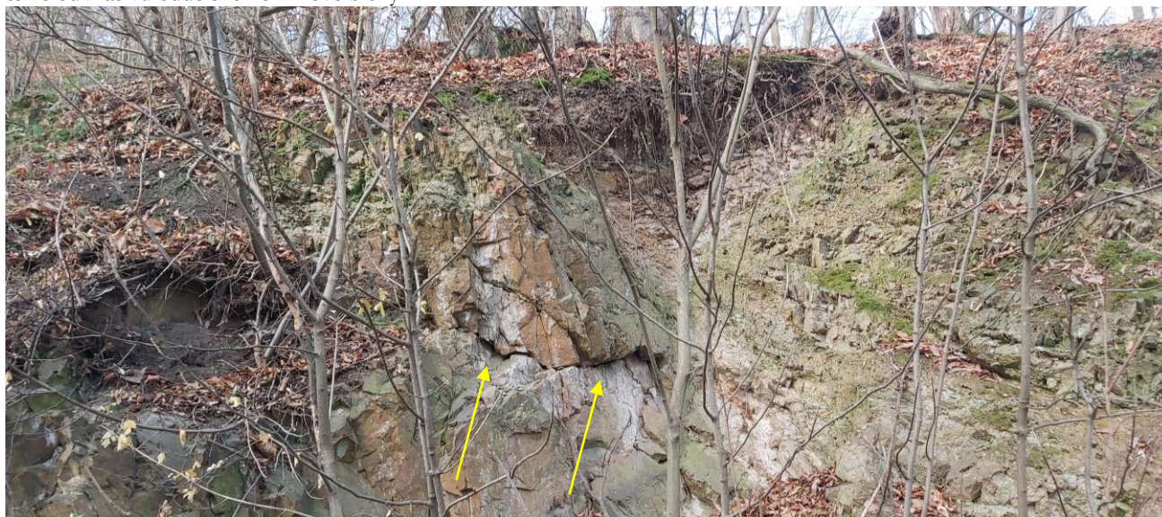
Foto 3 Detail jiné části skalního svahu v úseku A ukazující od masivu viditelně oddělené horninové bloky (žluté šipky).
