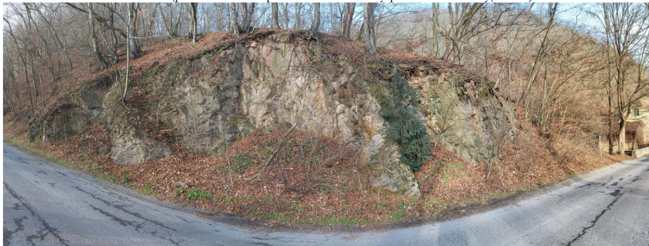
Foto 1 Skalní svah úseku A v rámci skalního zářezu silnice II/201. Převládají slabě zvětralé břidlice a žila andezitu, které jsou jen lokálně porostlé vegetací. Horninový masiv je porušen podél subvertikálních puklin (detail viz foto 2).
