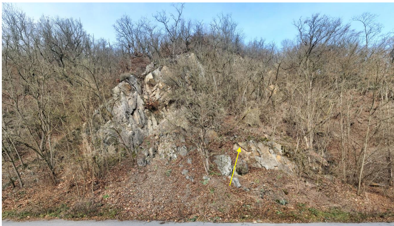
Foto 14 Poměrně nevelký skalní svah v úseku D. I v rámci něj však byl zjištěn potenciálně nestabilní horninový blok ( žlutá šipka ; detail viz foto 15).
