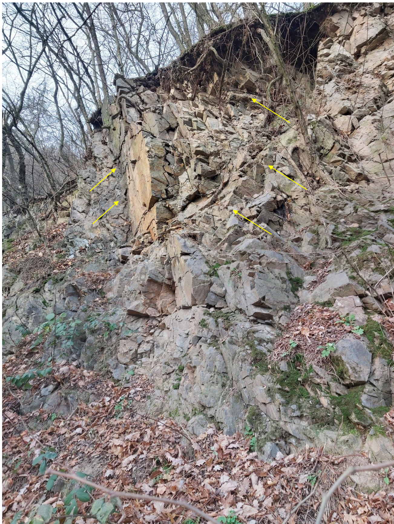
Foto 23 Detail úseku G s nestabilními horninovými bloky, které bude bezpodmínečně nutné odstranit pro zachování bezpečnosti provozu na silnici II/201.
