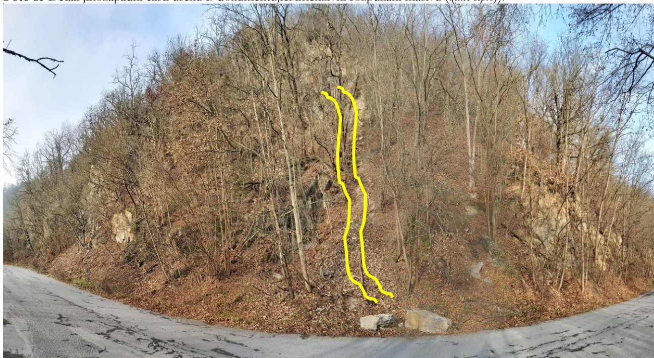
Foto 11 Skalní svah úseku C v rámci skalního zářezu silnice II/201. Zde bylo dokumentováno skalní říční ( žluté křivky ), během něhož došlo k uvolnění několika m 3 hornového materiálu (detail viz foto 12, 13). Odlučná oblast se nachází v nepřístupné části skalního svahu. Je proto nutné provést s použitím horolezecké techniky detailní geotechnický průzkum, který by určil míru porušení masivu v horních partiích svahu.
