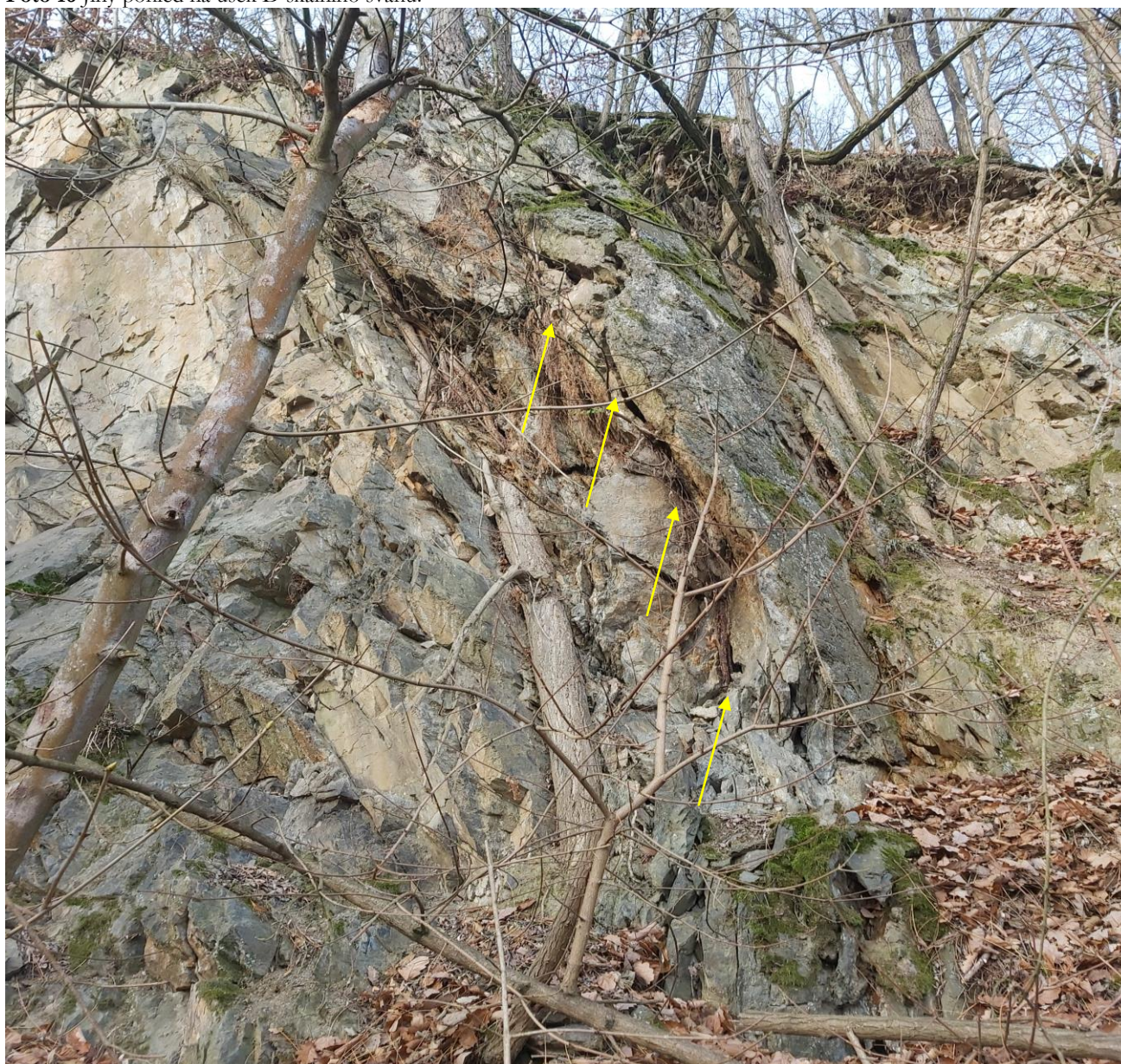
Foto 17 Rozsáhlé porušení skalního masivu v seku D ( žluté šipky ), které je nutno řízeným způsobem odstranit.
