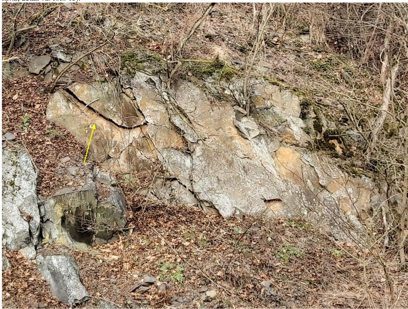
Foto 15 Detail úseku D. Žlutá šipka ukazuje na viditelně od masivu oddělený horninový blok, u něhož v budoucnu existuje reálná možnost dopadu do prostoru silnice II/201.
