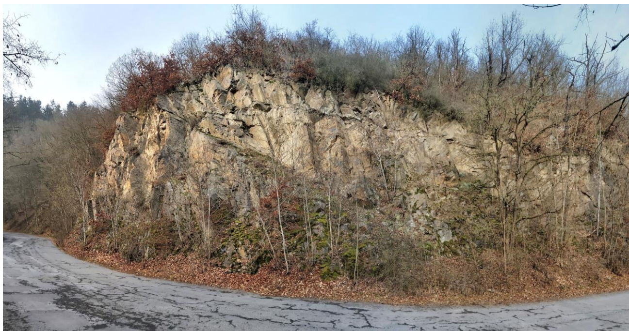
Foto 18 Skalní svah v úseku E. Skalní svah je zde porušen systémem relativně plochých puklin (detail viz foto 19).
