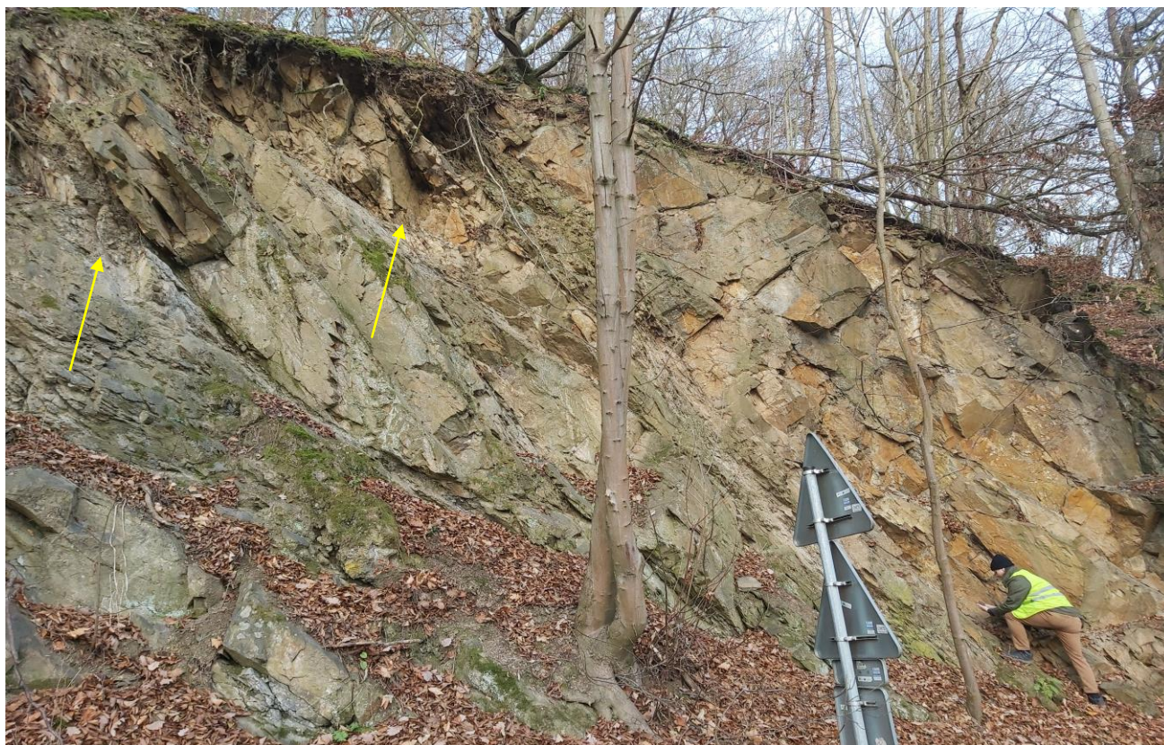
Foto 7 Další potenciálně nestabilní část masivu v rámci posuzovaného úseku B, již bude nutné odtěžit (žluté šipky).
