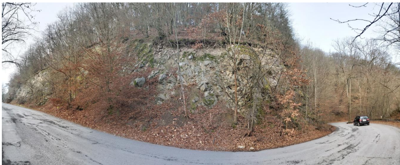
Foto 24 Úsek H v rámci, kterého byly identifikovány zcela rozvolněné partie svahu (detail viz foto 25).
